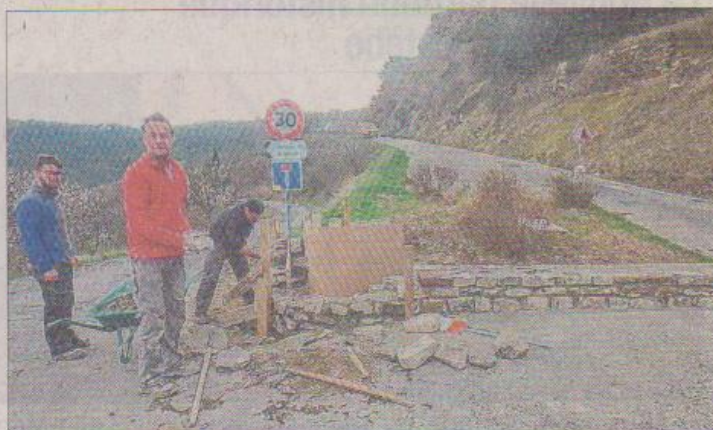
La construction du muret avance à Naves.
